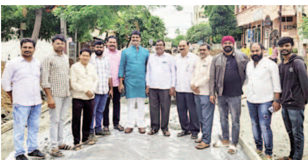
సిసి రోడ్డు పనులను పరిశీలిస్తున్న కార్పొరేటర్ లచ్చిరెడ్డి తదితరులు
